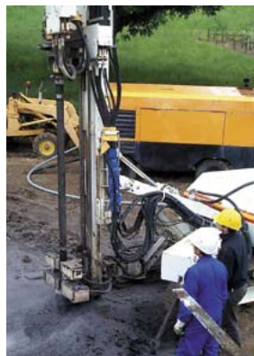
Pose d'une sonde géothermique
