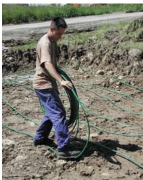
Pose de capteurs horizontaux
